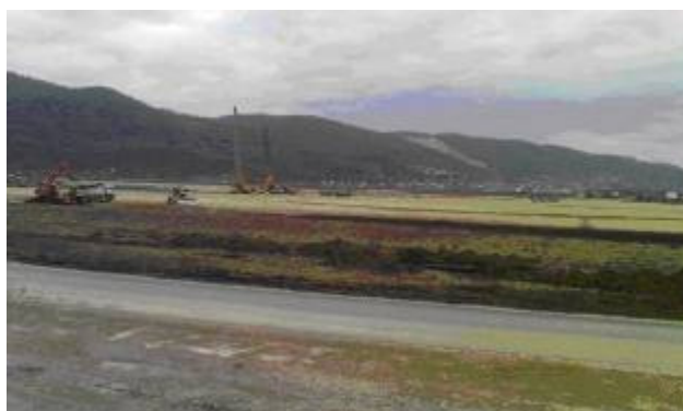
Radovi na gradilištu West Gate-a
